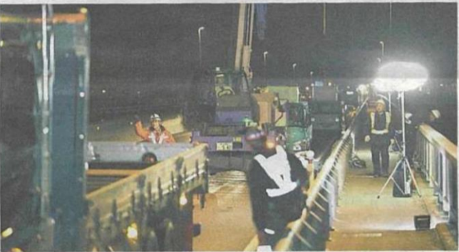
深夜、阿賀野川大橋の工事現場で働く人たち。私たちの暮らしを支えるため、深夜や早朝も奮闘する
