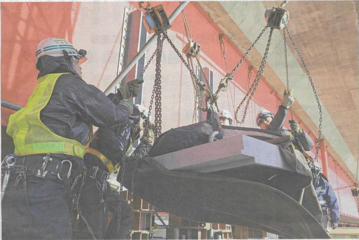
阿賀野川大橋の補修工事に勤む作業員ら。寒い中、橋の下に入り、外からは見えない損傷を直していた
