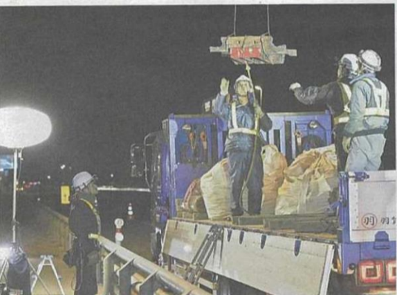
部材を橋の下から、橋の上に搬出する作業。車線を規制するため、車の通行量が少ない夜間に行う
